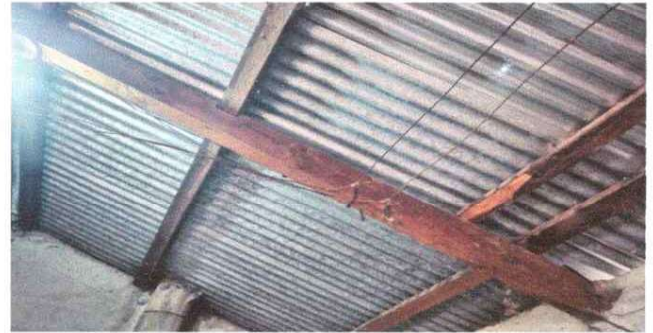
Foto 2: Sustitución de soporte de madera, por metal.
