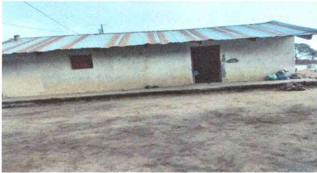
Foto 1: Sustitución de lámina, por lámina troquelada.
