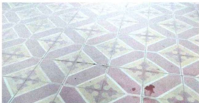
Foto 7: Sustrucción de piso mosaico por cerámico módulo No. 2
