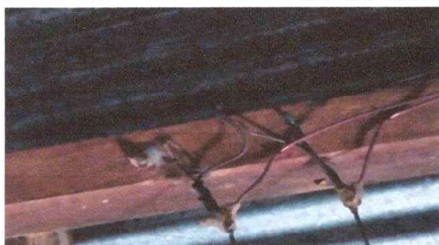
Foto 9: Reparación de sistema eléctrico en Cocina.
