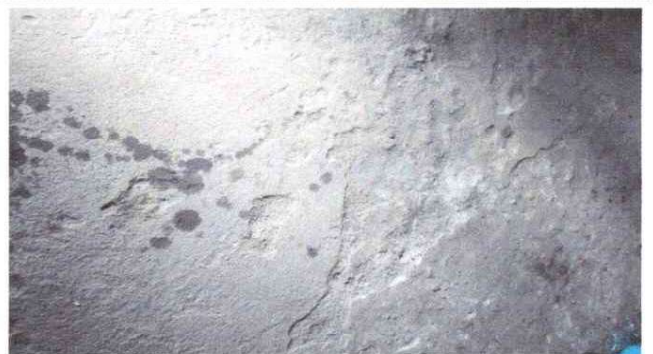
Foto 4: Sustitución de piso de torta a cerámico en cocina.
